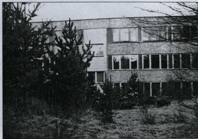
Den obertägigen Anlagen wie diesem Verwaltungsgebäude mit direktem Zugang zum Bunker, sieht man ihre strategische Bedeutung nicht an; dem Sicherheitsstreifen mit Elektrozaun rings um das Bunkergelände schon
